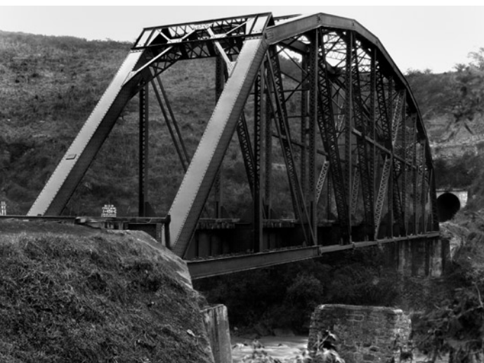
© Puente de armadura tipo Parker en el río Tuxpan, 1929. Fondo Comisión de Avalúo e Inventarios. CONACULTA/CNPPCF/MNFM.
