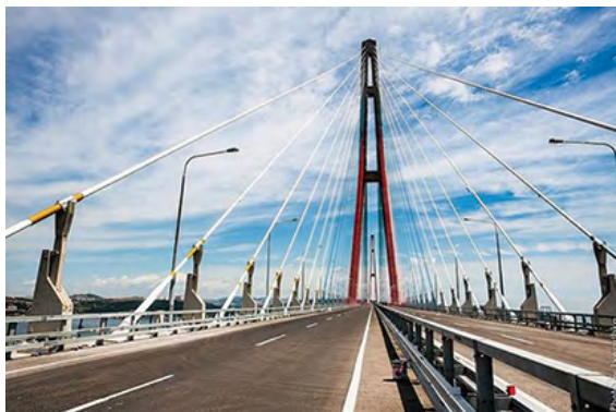
Figura 5. Puente colgante de la Isla Russky que la conecta a la ciudad de Vladivostok, Rusia. Este puente está formado por materiales ferromagnéticos cuya salud estructural podría ser monitoreada usando el método de memoria magnética.
